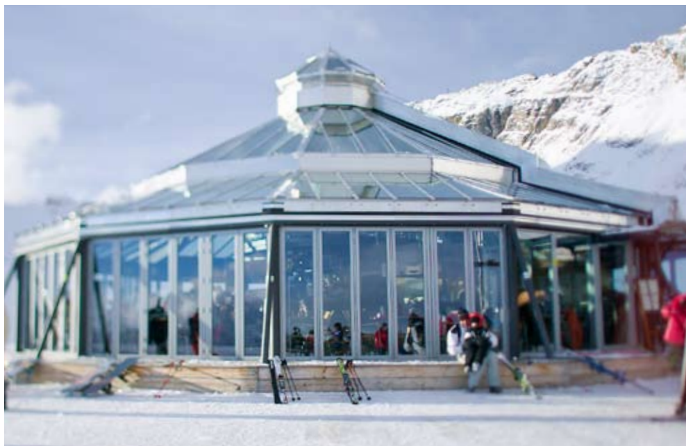
← Restaurant „Gletschergarten“, Zugspitze Ausführung: NEUTRALUX® advance /// Foto: © Arnold Glas
