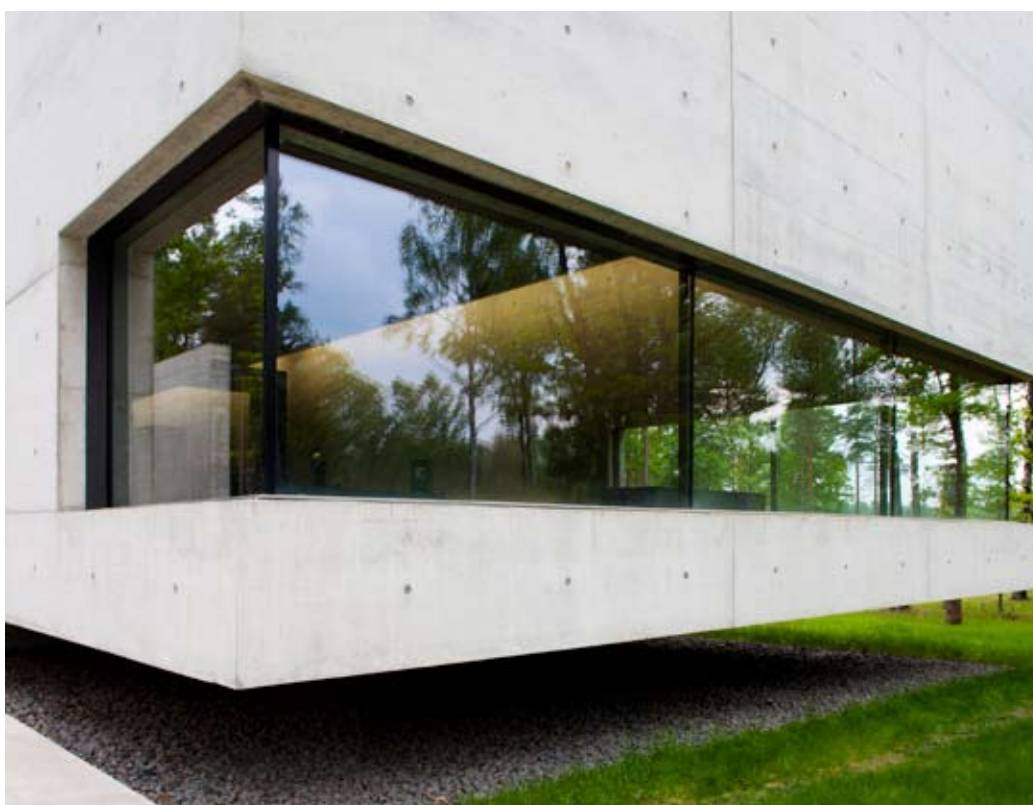
← Dokumentations- und Informationszentrum der Gedenkstätte Bergen-Belsen, Ausführung: NEUTRALUX® advance // Foto: © Arnold Glas
